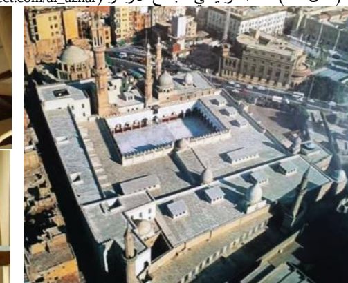
شكل (٣١) الأزهر من أعلى وتظهر القباب والإضاءة العلوية (المصدر: http://rsce.eng.cu.edu.eg/project.aspx?pid=1000057 )
