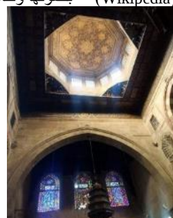
شكل (٥٢) إضاءة الشخشيخة فوق الصحن
